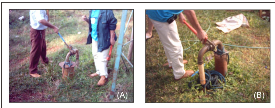
Figura 14 - Poços sem selo sanitário: (A) P9 e (B) P11.
