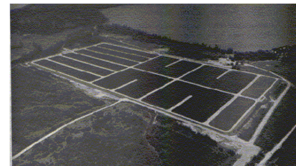
Sistema de tratamento de esgoto por lagoas de estabilização Porto Alegre (260 mil)
